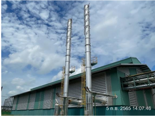
รูปที่ 1 ปล่องระบายหม้อไอน้ำ
